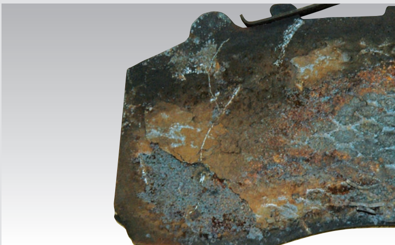
► Intenzivno prodiranje korozije
